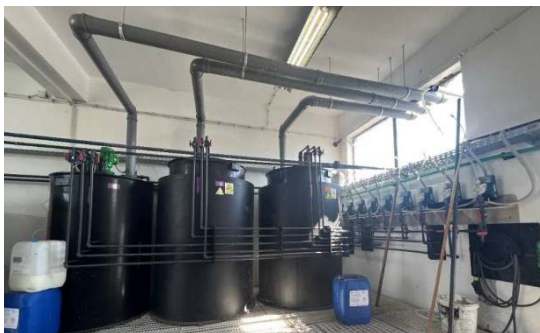
Slika 2. Izgled hemijske stanice nakon sanacije Figure 2. Appearance of the chemical plant after remediation
